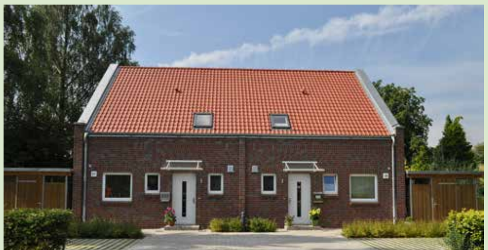
Neubau in der Strengesiedlung: Schuhkarton als Lebensraum?
